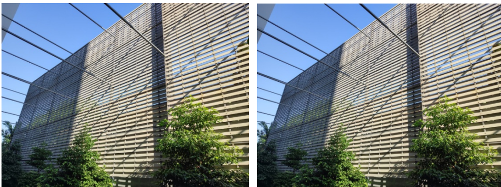
ภาพที่ 10-6 ติดตั้งระแนงเพื่อป้องกันความเป็นส่วนตัวของบ้านเลขที่ 940 และป้องกันลมร้อนจากเครื่องปรับอากาศ
